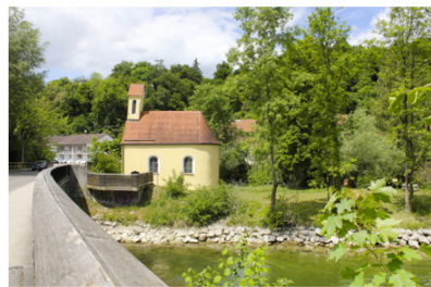
St. Nikolauskapelle an der Amper
