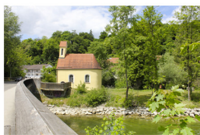
St. Nikolauskapelle an der Amper
